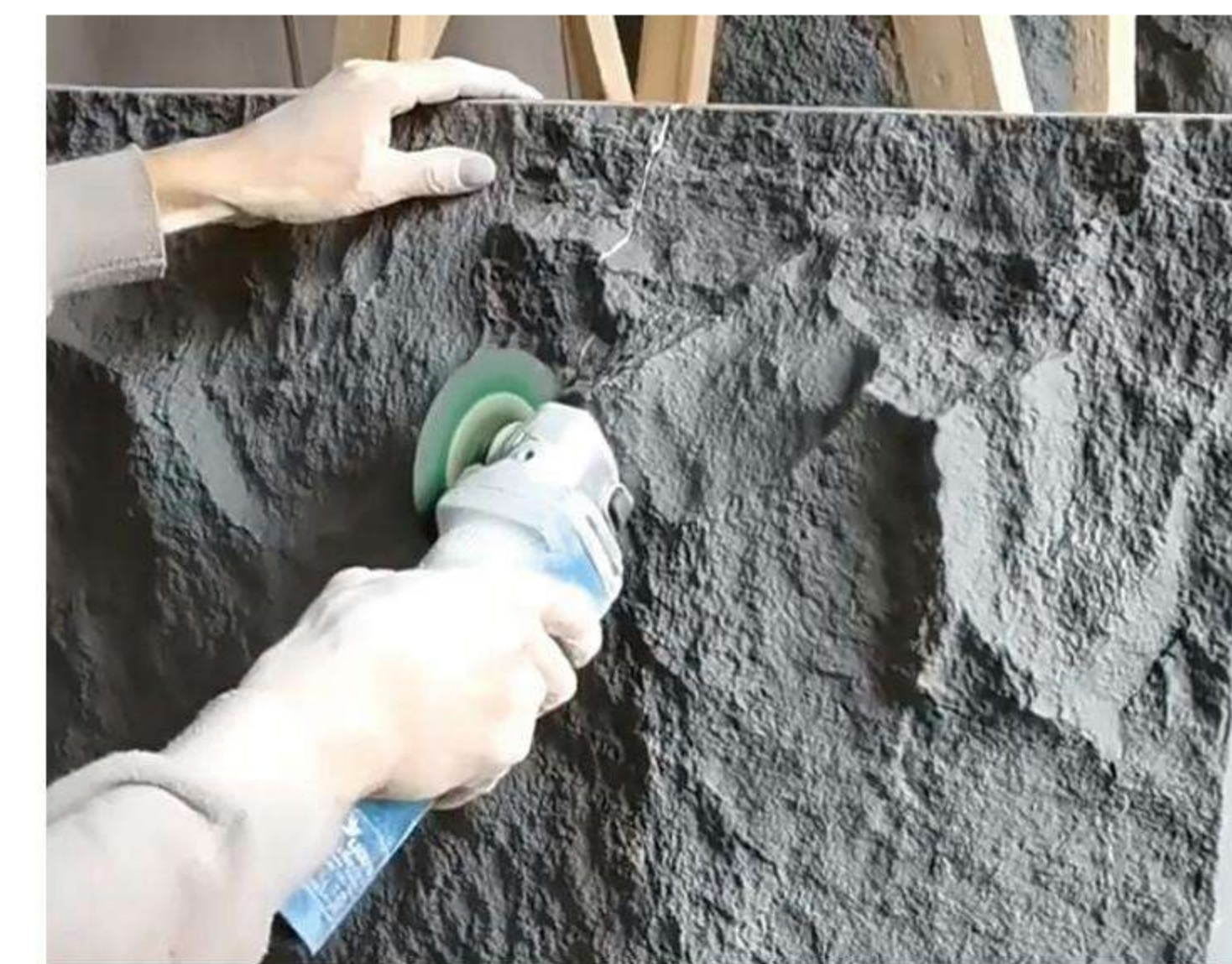
1.Cutting PU Stone Panels
