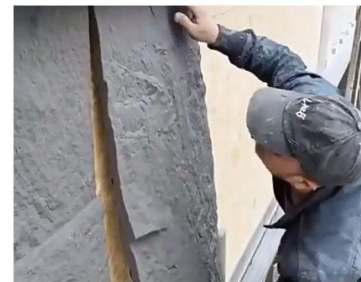
3.Installing PU Stone Panels
